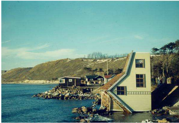
Fig. 1. Det första huset som byggdes i Löderups Strandbad underminerades och föll i havet 1975.
