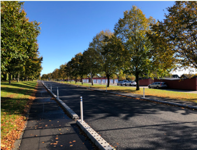
Längs Missunnavägen har körbanan smalnats av och kompletterats med betongstöd där i första hand cyklister kan cykla, åtskilda från biltrafiken.
