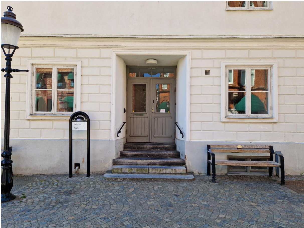
Befintlig trappa av kalksten vid rådhusets sidoentré centralt placerad längs norra gavelfasaden. Illustration: Tengboms
