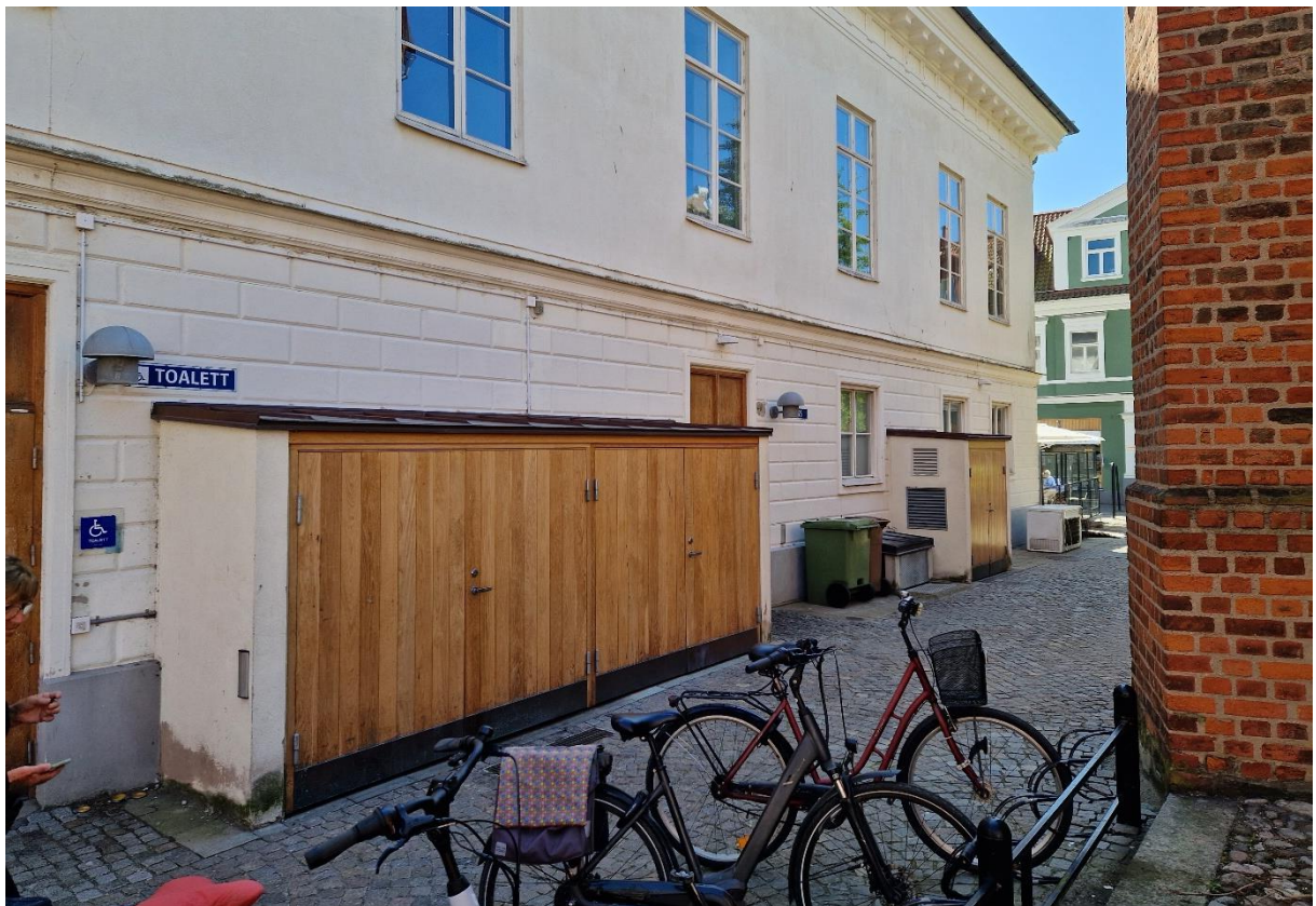
Befintliga tillbyggda miljörum efter rådhusets västra fasad.
