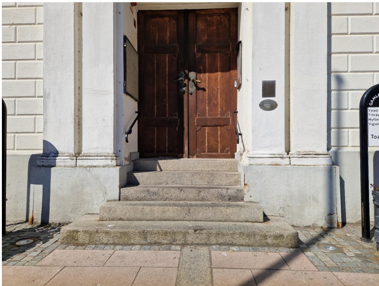
Befintlig trappa av granit vid rådhusets huvudentré centralt placerad längs östra långsidan.
