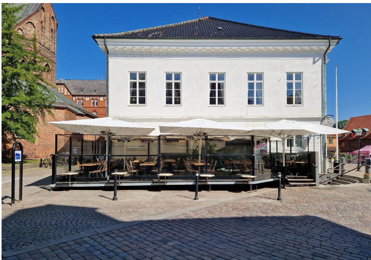
Gamla Rådhuset, södra gavelfasaden.
