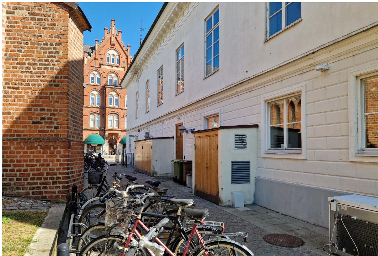
Befintliga tillbyggda miljörum efter rådhusets västra fasad.
