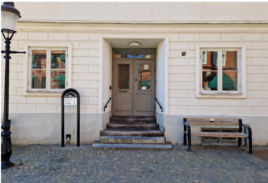
Befintlig trappa av kalksten vid rådhusets sidoentré centralt placerad längs norra gavelfasaden.
