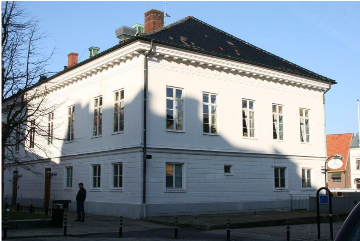
Gamla Rådhusets södra gavelfasad under tidigt 2000-tal. Här syns hela fasaden utan dagens löst stående struktur med uteservering. På marken direkt intill fasaden syns det betongbjälklag som utgör golvet till uteserveringen och tak till det underliggande köket. Här syns också den västra långsidan innan befintliga miljöhus tillbyggnader. Foto: Björn Bjelke Holtermann.
