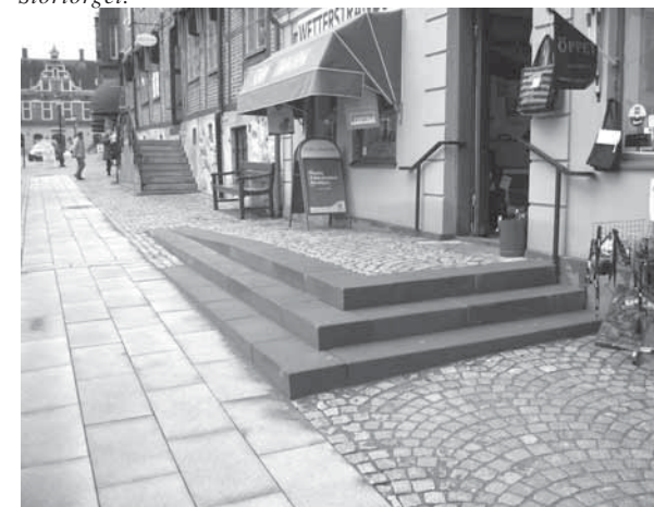
Ett bra exempel på utformning av entré. Den mörka trappan kontrasterar tydligt mot den ljusare stenslagningen. Stortorget.
