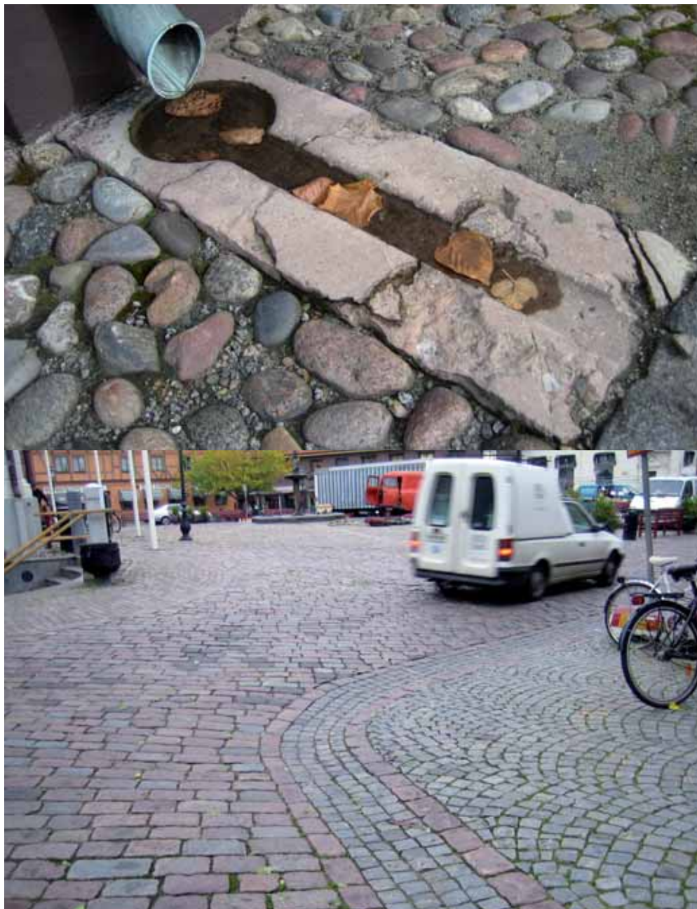
Ett vackert exempel på av- vattningsränna, från slutet av 1800-talet, men kanske inte så lämplig att gå på.
