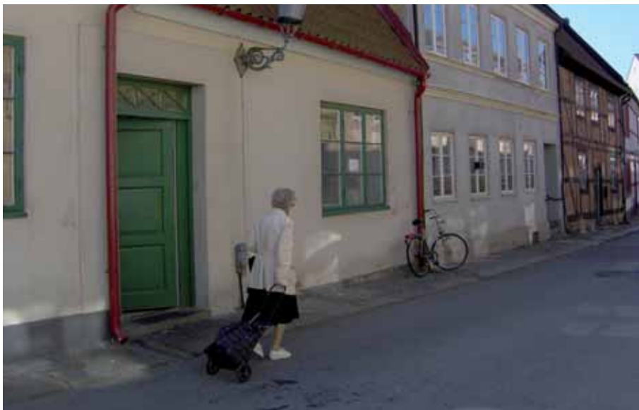
Smala trottoarer med ojämn beläggning är svåra att gå på. Jämnt belagda stråk bör finnas genomgående.
