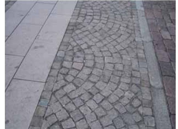
Markbeläggningen signalerar tydligt olika användningsområden. På bilden granithällar, smågatsten, kantsten och storgatsten i olika variationer. Exempel från Hamngatan.
